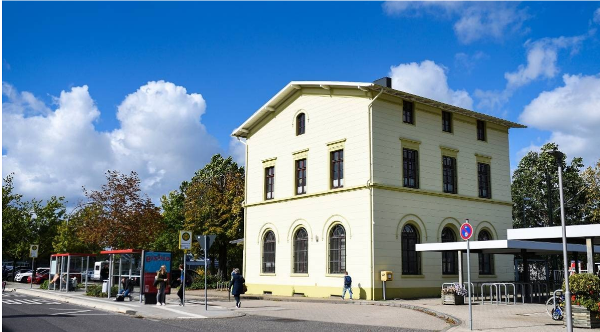
Das alte Bahnhofsgebäude in Kleinenbroich. Foto: Bauch, Jana (jaba)
